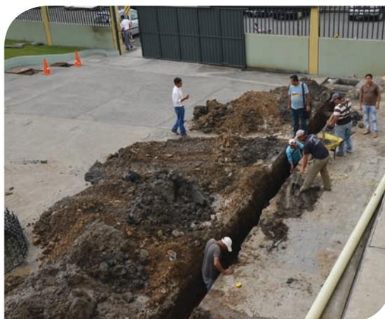
**Figura 137:** Remoción e instalación de tuberías del Sistema Contra Incendios.
