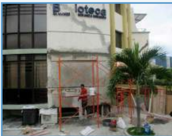
Figura No. 548: Colocación de paredes de bloques en la Biblioteca General
