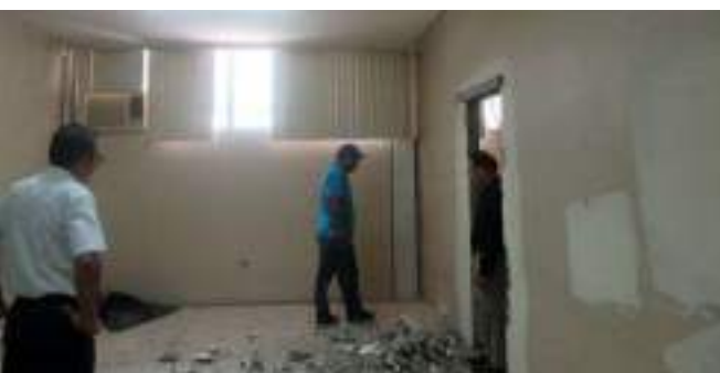
Figura No. 529: Remodelación de antigua oficinas de la carrera de Comercio Exterior para el funcionamiento de la Unidad de Desarrollo Humano
