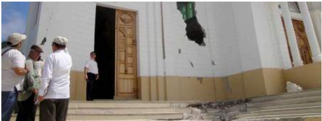
Figura No. 253: Inspección en Sitio - Iglesia Nuestra Señora de Monserrate
