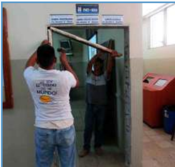
Figura No. 532: Instalación de puerta de aluminio y vidrio claro en aula de clases
