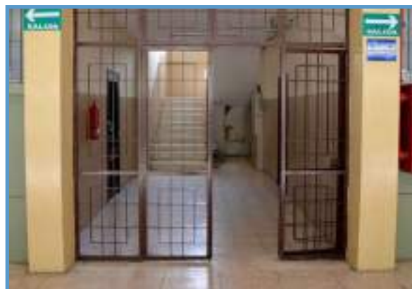
Figura No. 537: Instalación de señaléticas de evacuación en los pasillos
