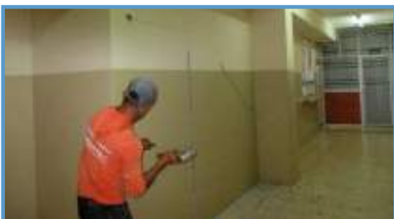
Figura No. 542: Se picó, reparó y empastó la pared de entrada a la Secretaría de la Fac. de Ingeniería, Industria y Construcción
