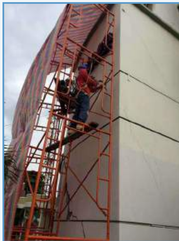
Figura No. 547: Inicio de demolición de paredes de la Biblioteca General
