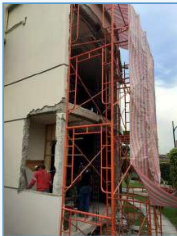
Figura No. 549: Demolición pared izquierda y derecha de la Biblioteca General
