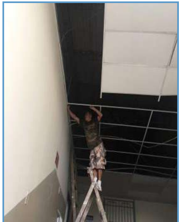
Figura No. 544: Colocación de nuevas planchas de yeso en tumbado de pasillo Edificio Dr. Francisco Campos Rivadeneira
