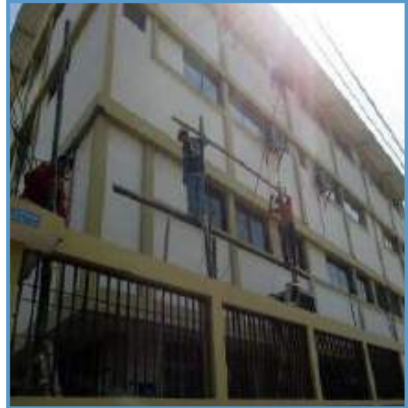
Figura No. 543: Reparación del Edificio Alfonso Aguilar Ruilova
