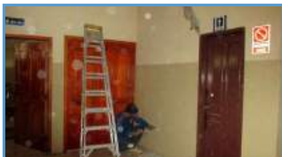
Figura No. 540: Arreglos en pared de entrada al baño de la planta baja
