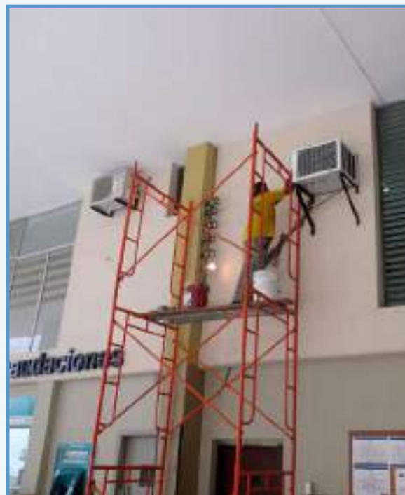
Figura No. 538: Reparación de pared en la entrada al departamento Financiero
