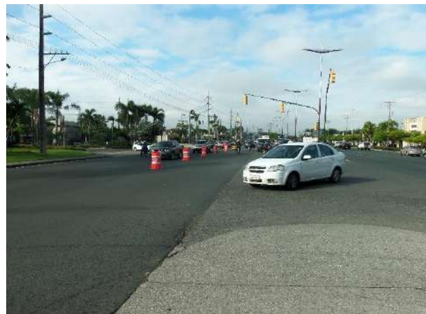
Figura 2. Colocación de Vallas Transitorias con trafitambo en Avenida Samborombón, sector Village Plaza (Fuente, Autores)
