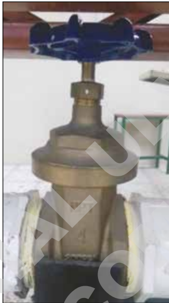
Figura 5. Válvula compuerta 4" – máx.: 300psi (PN 20 – NPT).
