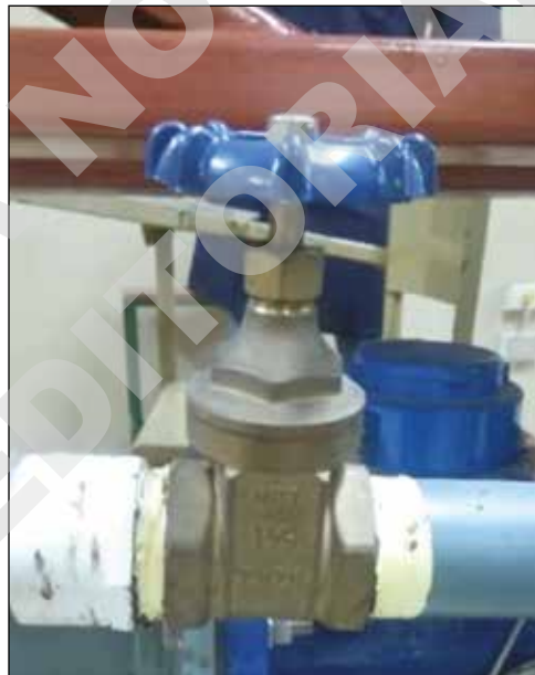
Figura 6. Válvula compuerta 1 ½" – 10-150psi (PN-20 – NPT).
