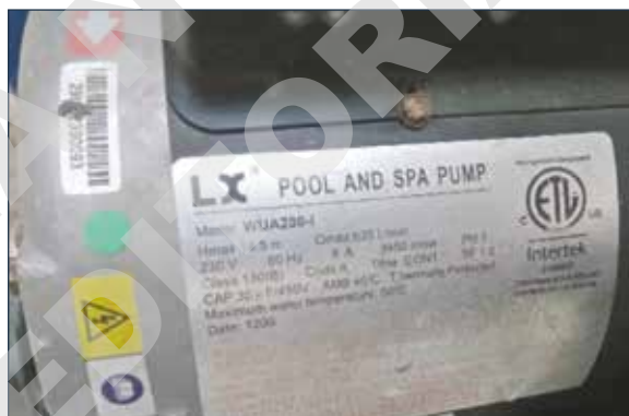
Figura 4. Arriba: Fotografía de la bomba y succión-impulsión; H máx. = 14.5m – Q máx. = 635l/min (XL POOL AND SPA PUMP Modelo: WUA 200-I). Debajo: Detalle de la misma bomba.
