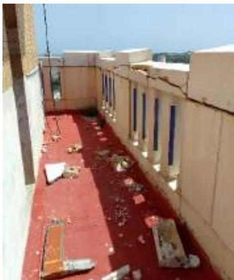
y desprendimiento de material. Los estudios termográficos realizados en la fachada principal muestran con mejor claridad las grietas presentes. Estas fueron provocadas por corrosión de los perfiles y piezas de anclajes existentes de soporte de los mármoles y ladrillos. La visual térmica refleja que las grietas se extienden a casi toda la altura del muro de fachada, lo que sugiere que el deterioro por corrosión es significativo (Figura 10).
