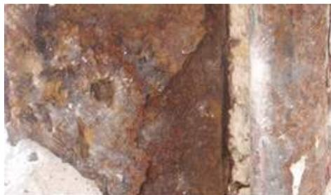
constituyen presentan corrosión generalizada, lo que coadyuva a la formación de las grietas horizontales laterales e inferiores del hormigón que las recubre, de estas vigas estudiadas la más crítica es la de la cala 3, (Figura 19).
