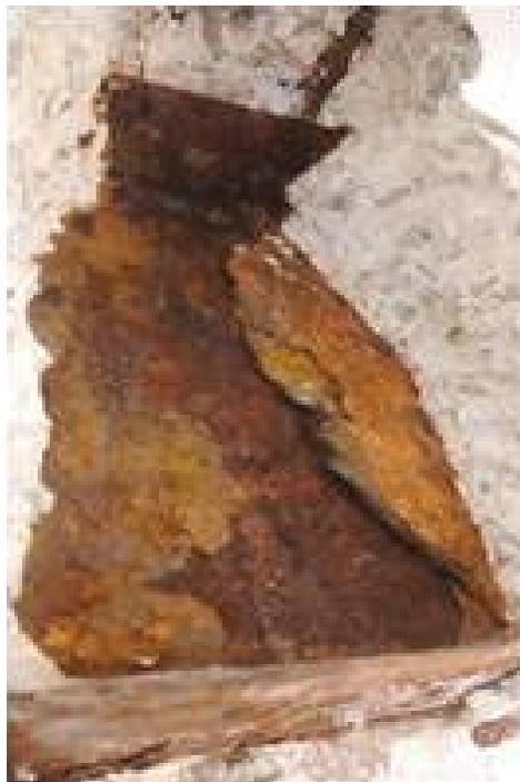
**Figura 19***Unión del tornapuntas con la viga. Se constató un refuerzo colocado por debajo de los dos lados inferiores de los perfiles tipo L*
